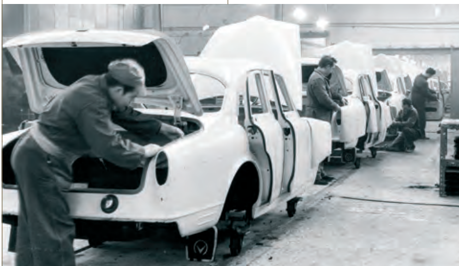
Les voitures étaient équipées de divers éléments de fabrication belge, comme le radiateur, les vitres, la batterie, les revêtements intérieurs et les pneus (photo Volvo Cars)
