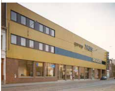
C'est dans cet ancien garage Peugeot d'Hoboken que fut installé en 1985 le siège de British Auto Center N.V.
