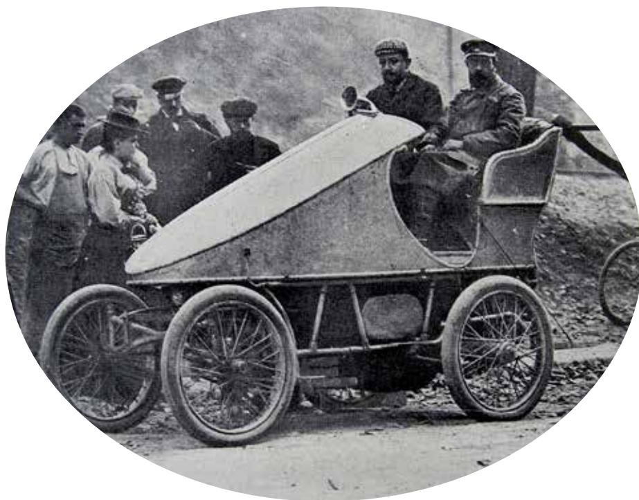
De Vallée van 'Flash' (een schuilnaam voor Edward Lewhess) was een echte racewagen met aerodynamisch koetswerk. Maar de aandrijving was nog met een riem, en de resultaten waren teleurstellend.
