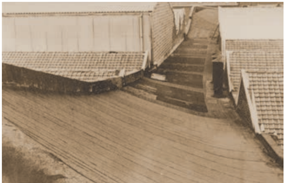
Een deel van de testpiste die was aangelegd op het dak van de Imperiafabriek in Nessonvaux.
